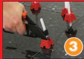
*Aprete tapas y tiras para que practicamente eliminen el desnivel de losa a losa.*
